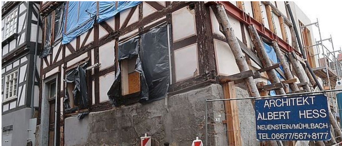
Foto: Erst Fenster ausgebaut, dann mit Folie notdürftig geschützt
