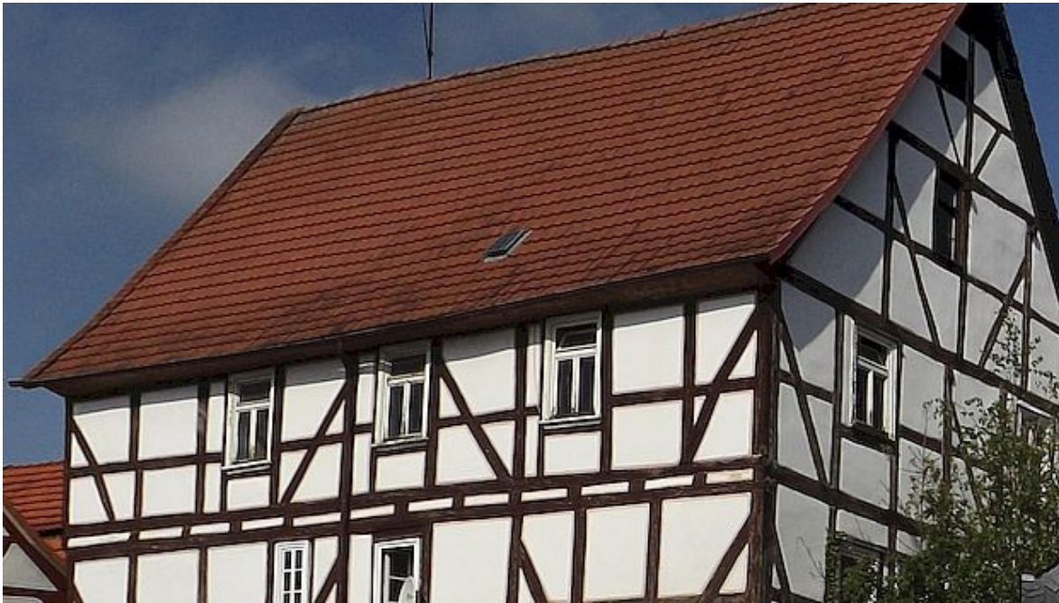
Foto: Ehemaliges Kulturdenkmal wurde zum größten Teil abgerissen unter dem falschen Vorwand es sei schadstoffbelastet
